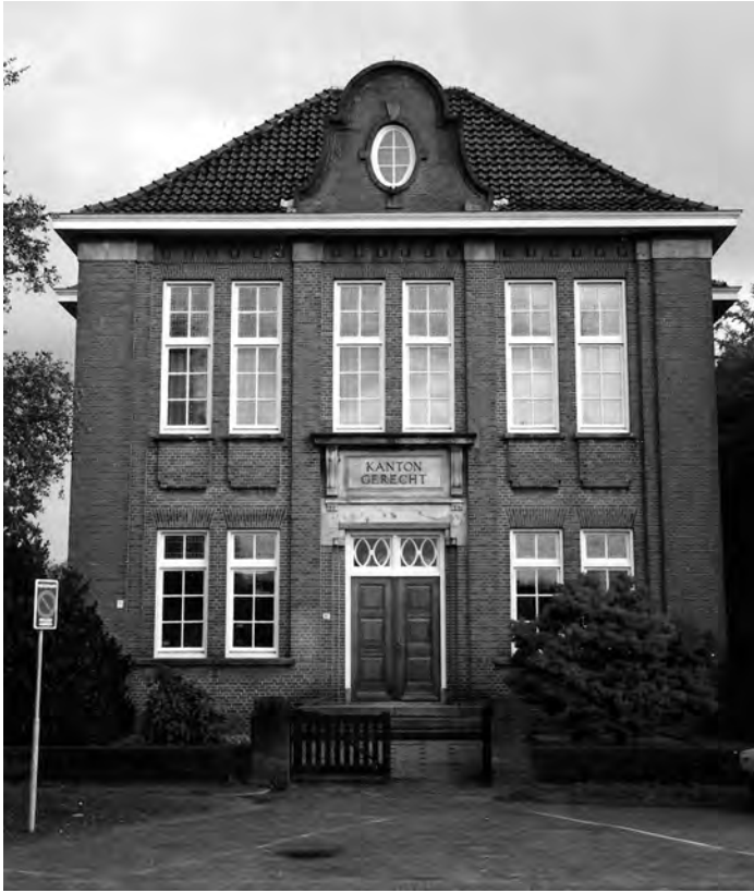
Het gebouw van het (voormalige) kantongerecht te Beetsterzwaag. Foto (midden jaren 1990): Alfred Meester.
