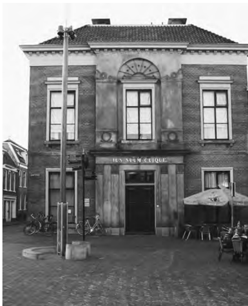
Het gebouw van de voormalige rechtbank te Sneek (in 2005 gefotografeerd door D.J. Glasbergen)
