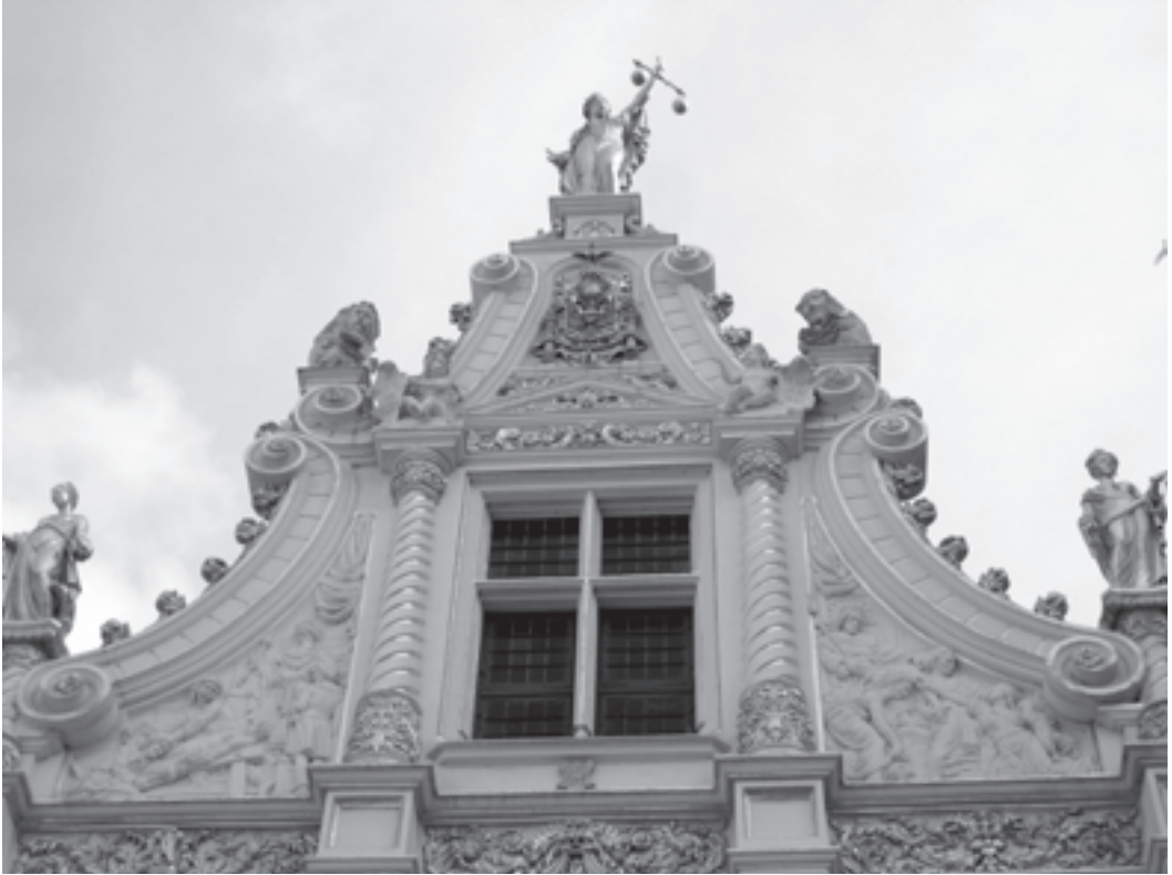
Detail uit de gevel van de burgerlijke griffie van de stad Brugge.
