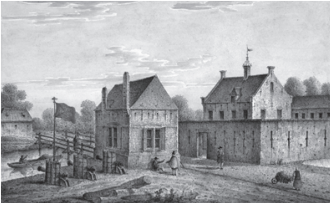
Negentiende-eeuwse aquarel van de Pasbrug door Jan-Baptist De Noter. Rechts bevindt zich (vermoedelijk) het gebouw van de officialiteit (© Stadsarchief Mechelen – www.beeldbankmechelen.be ).
